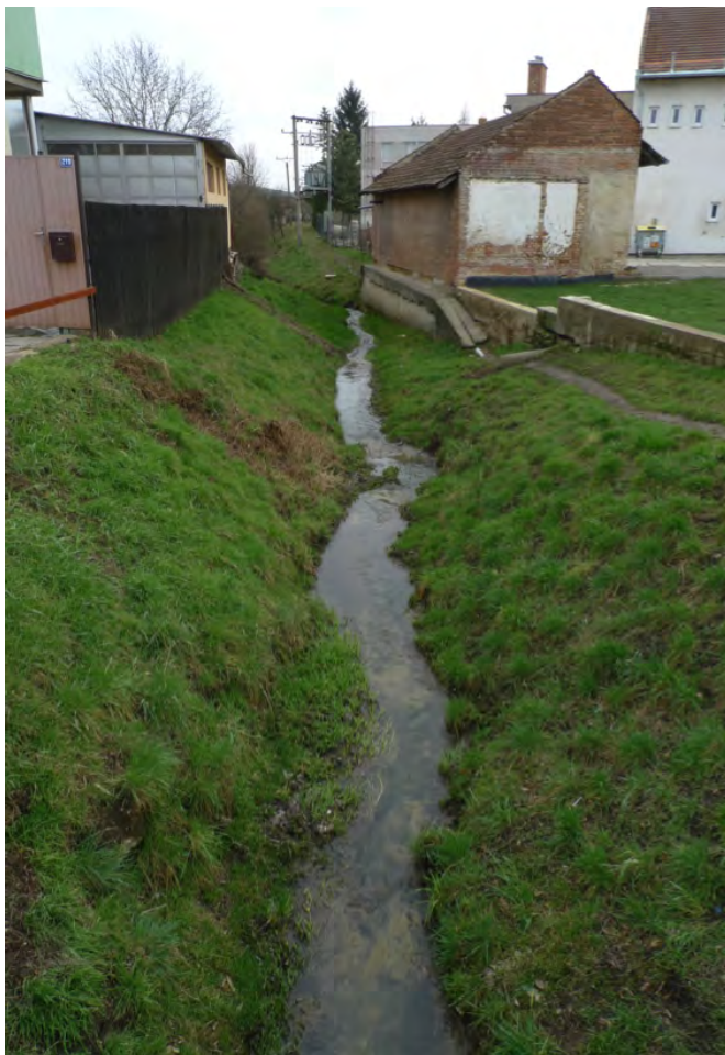
Obr. 2: Tok Malšinky v centrální části obce; patrné je značné znečištění, zahloubení a narovnání toku
